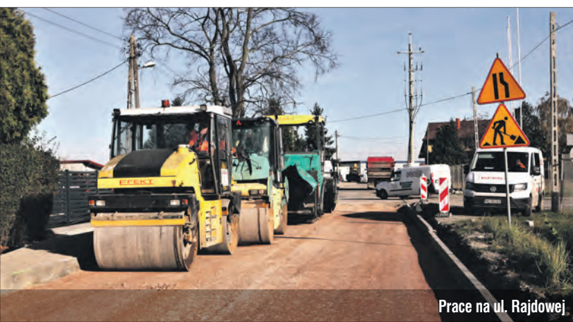
Nowa nakładka asfaltowa na ul. Ogrodniczej
