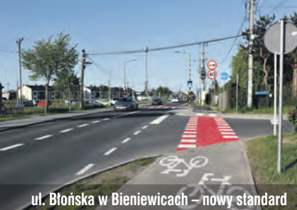
Nowa nakładka asfaltowa i bariery zabezpieczające na ul. Błońskiej w Bieniewicach
